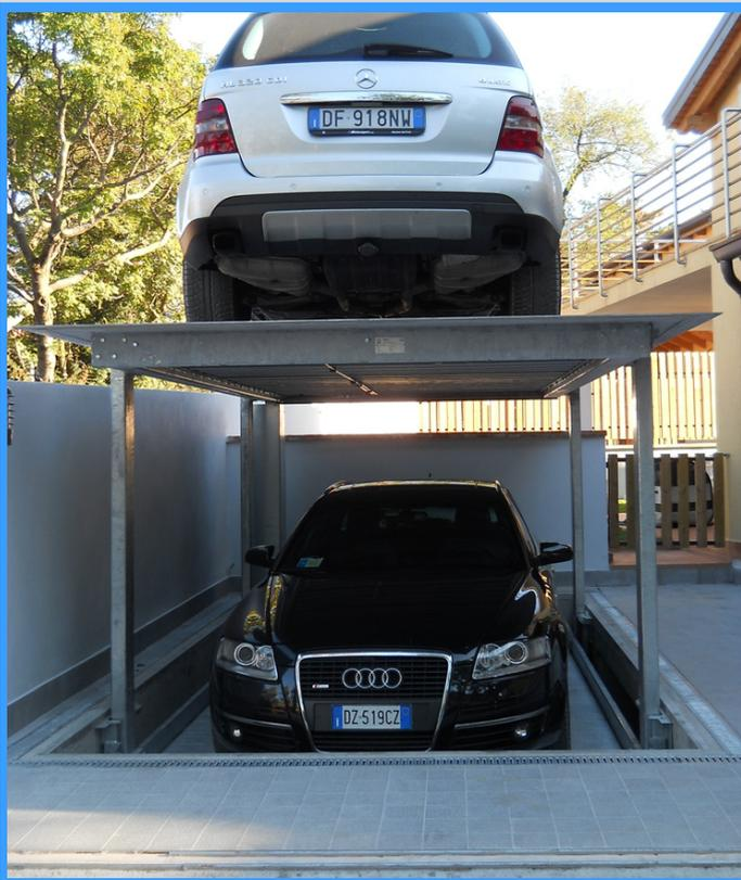
Deux plateformes solidaires en profils galvanisés à chaud Capacité de charge ; 2500kg par plateforme
